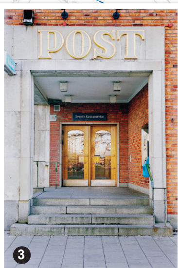
3 Brommaposten vid rondellen uppfördes 1948 av arkitekt Lars-Erik Lallerstedt, som en viktig del i av den tidiga centrumanläggningen. Foto: Johan Stigholt, Stockholms stadsmuseum.
