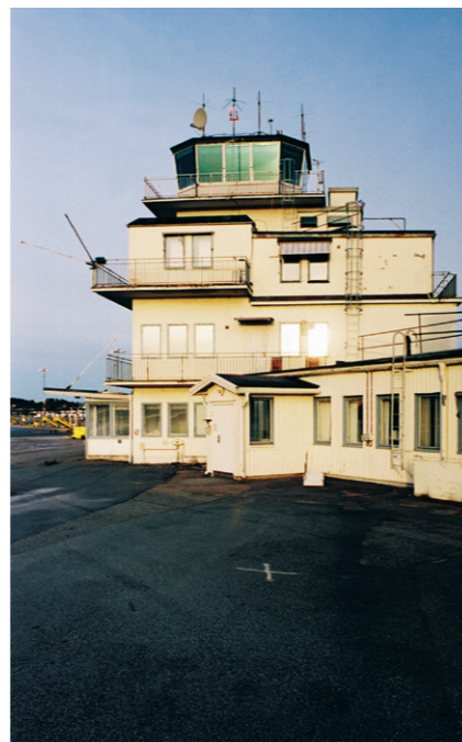
Flygedartornet på Bromma flygplats ursprungliga stationsbyggnad, uppförd 1936, var i bruk fram till 2003. Foto: Josefine Bolander, Stockholms stadsmuseum.
